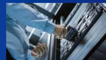
现场施工/安装调试
